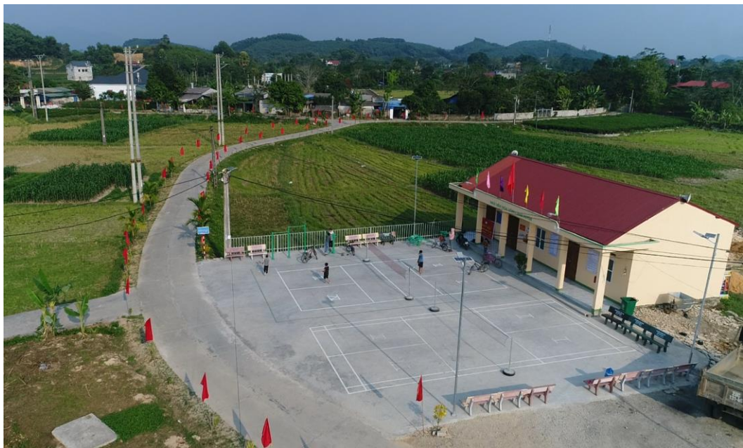
Các tuyến đường được chỉnh trang GTNT, vệ sinh hàng tháng đảm bảo sáng - xanh - sạch - đẹp
