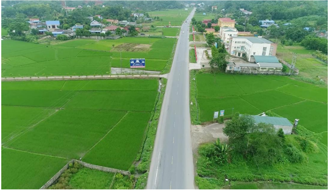
Tuyến đường Quốc lộ 3 -Thị trấn Du, huyện Phú Lương
